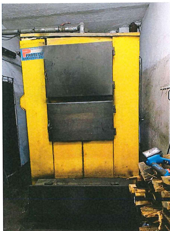
Rys. 7 Źródło ciepła – Kocioł węglowy Prod. Protech KARO; 200 KWt; 84% spr.
