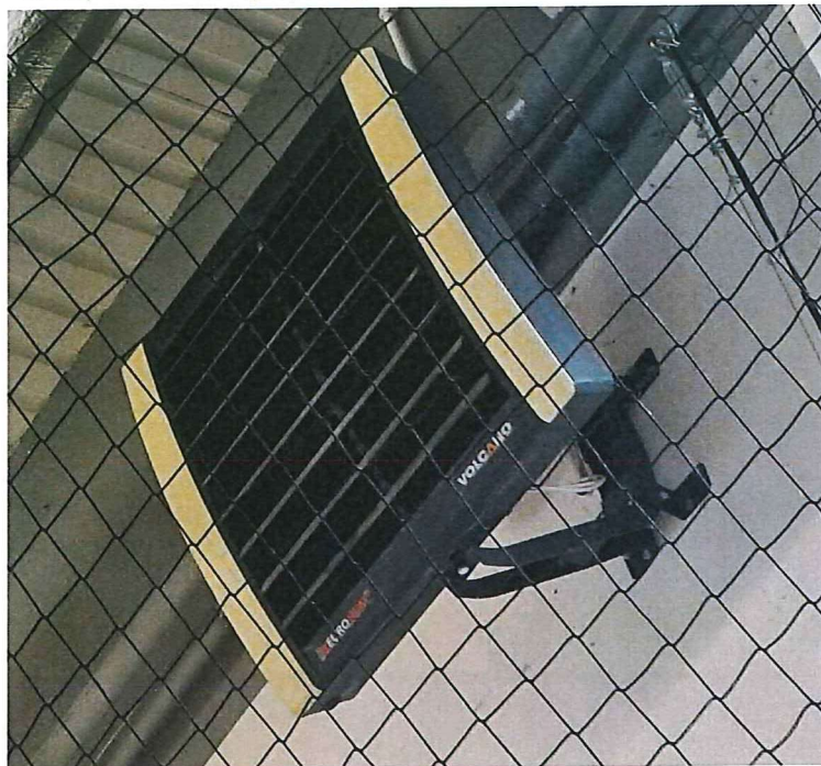
Rys. 11 Nagrzewnice wodne typu Volcano – ogrzewanie pomieszczenia Hali Gimnastycznej
